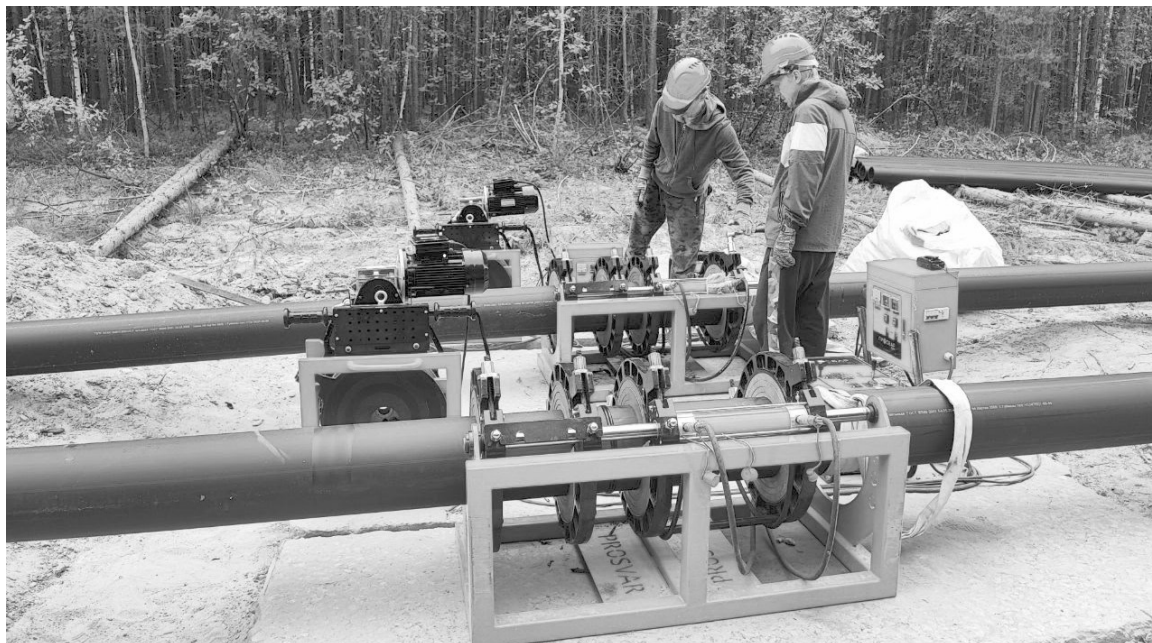
Ремонт магистрального водовода.
