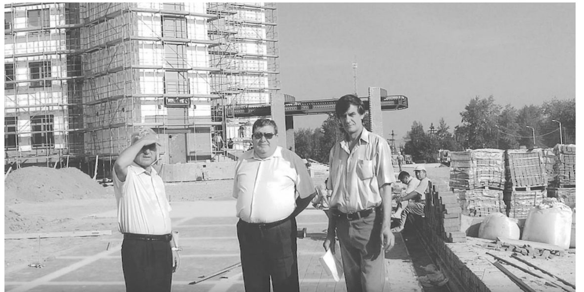
Федор Бескиер (в центре) возле строящегося здания предприятия «Газпром трансгаз Югорск».
