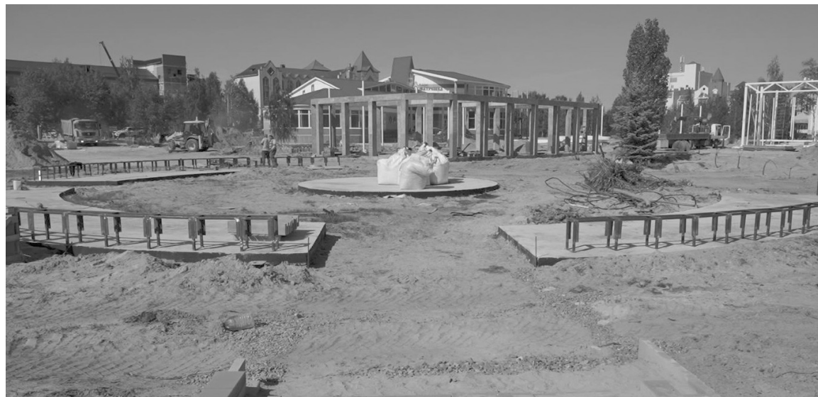
Реконструкция сквера «Северное сияние» будет завершена осенью этого года.
