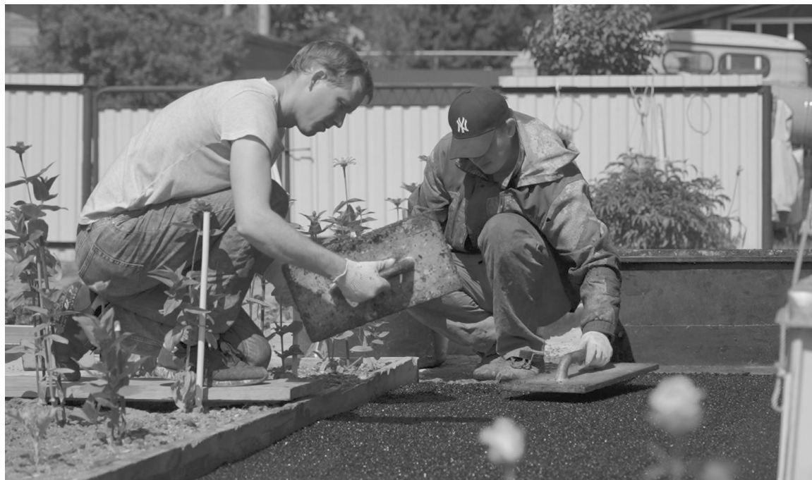
Укладка резинового бесшовного покрытия требует аккуратности и терпения.
