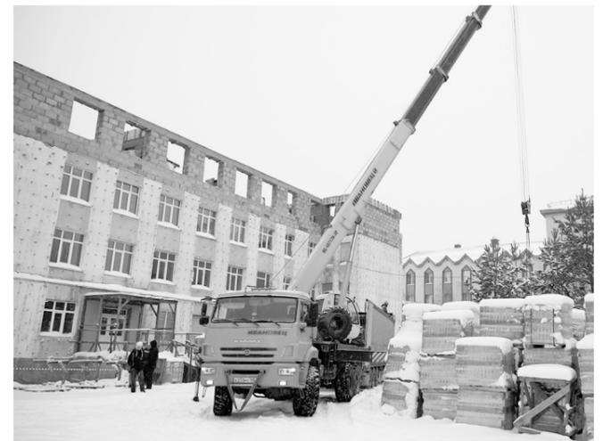
Строители практически завершили демонтаж внутренних перекрытий, провели усиление фундамента и приступили к его утеплению. Также продолжается возведение дополнительного четвертого этажа, на котором расположатся три лаборатории. Параллельно с этим идет строительство двух лифтовых шахт.
